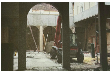
TRAVAUX DE LA COUR, 2008
