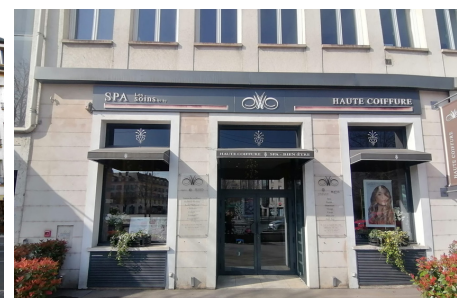
DEVANTURE DU SPA APRES TRAVAUX
