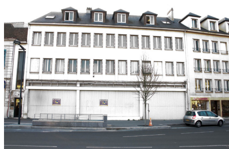
DEVANTURE DU SPA AVANT TRAVAUX
